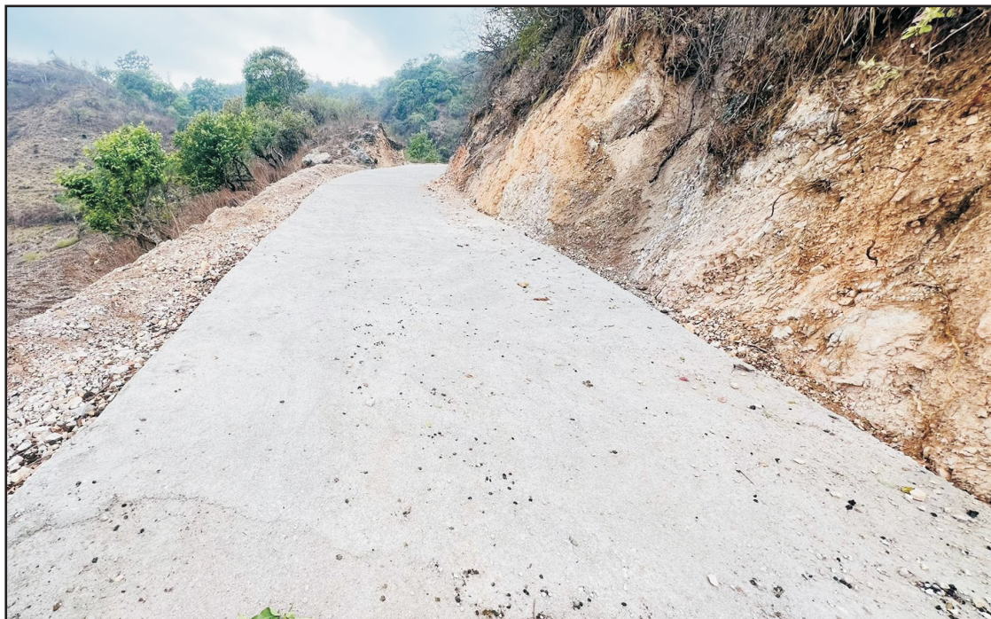
चरचरे-मरामकोट सडक अन्तर्गत ढलान कार्य
